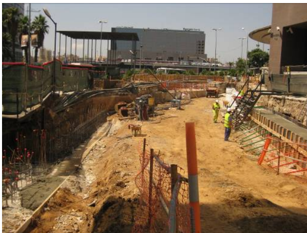
111. Vista general dels moviments de terres
