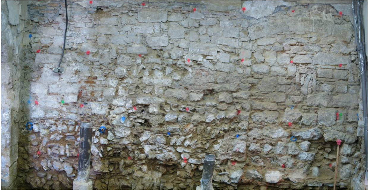
29. Parament interior mur UE 1015 i porta UE 1109
