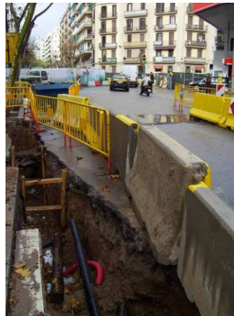
90. Rasa oberta al creuament entre els carrers de Mallorca i de Biscaia
