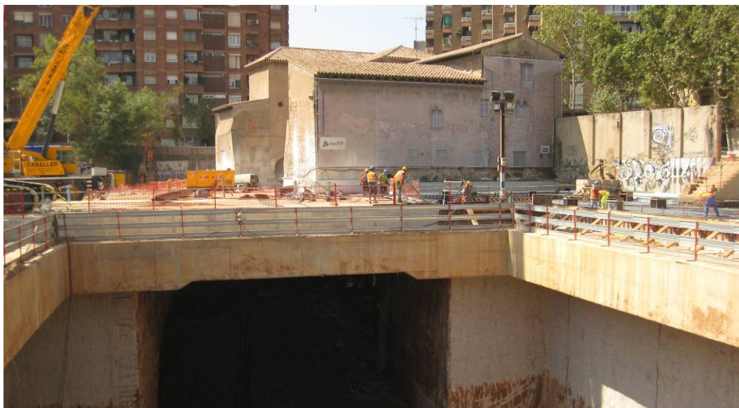
Vista del túnel sota l'edifici de la Torre del Fang
