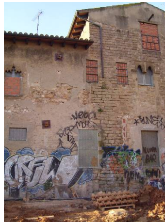
12. Detall del canvi de parament entre el mur UE 3026 (fase 2), i el mur UE 6041 (fase 3), a la façana septentrional
