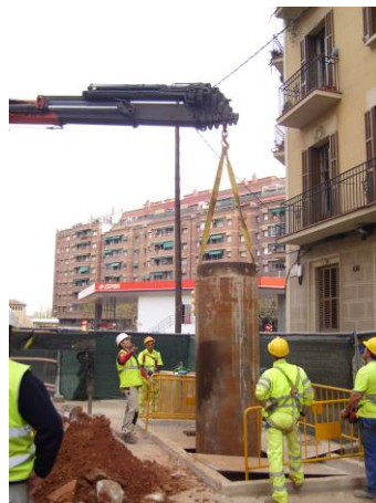
92. Treballs de buidatge del pou UE 206
