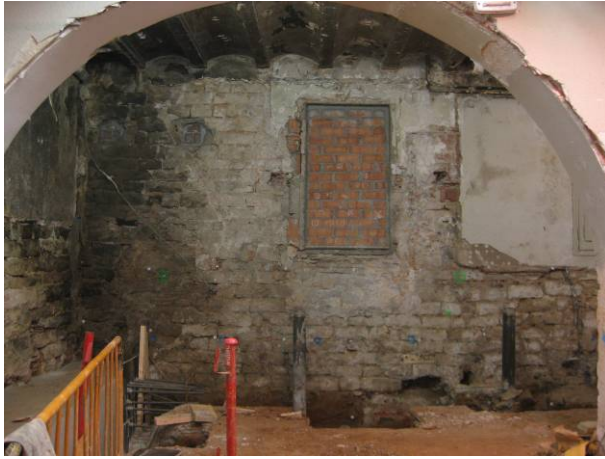
17. Parament interior UE 3026
