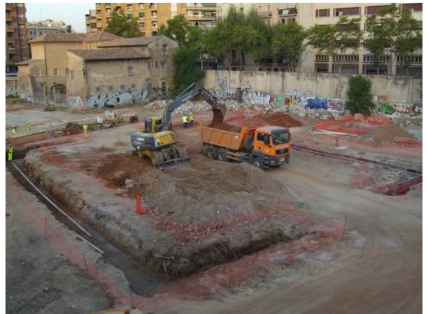
4. Rases dels murs guia utilitzades també com a rases informatives, a les proximitats de la Torre del Fang
