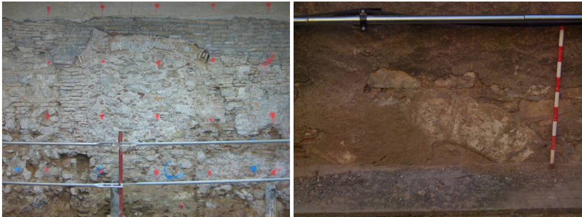
Porta UE 1072 des de l'interior i l'exterior de l'edifici.
