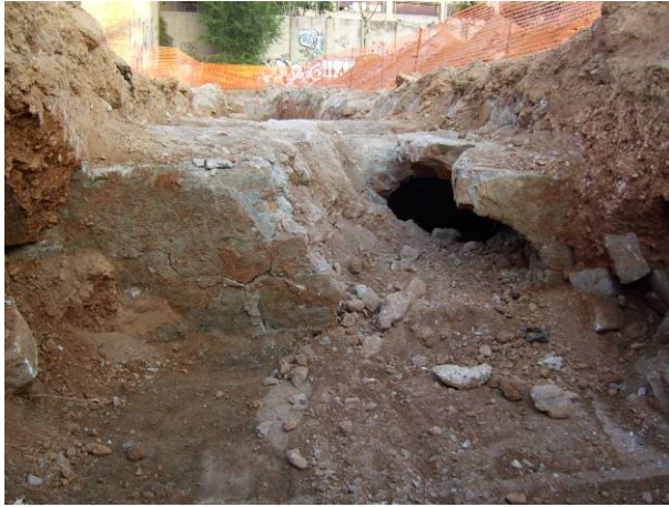
5. Mur de formigó UE 106 i col·lector actual
