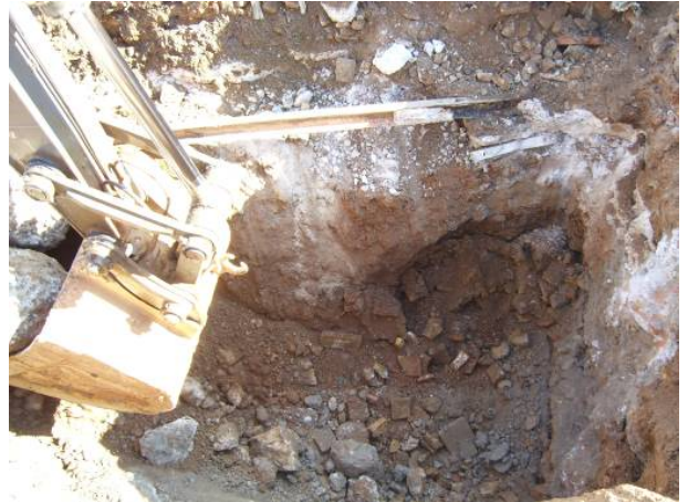
8. Obertura del subsòl pròxim al tram de mina documentat per localitzar la seva continuació, amb resultats negatius
