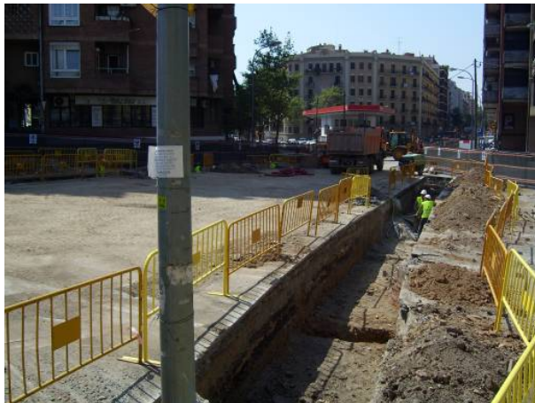
85. Moviments de terra al creuament entre els carrers de Mallorca, el Clot i Espronceda
