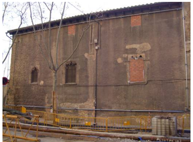
10. Vista de la façana occidental de la Torre del Fang
