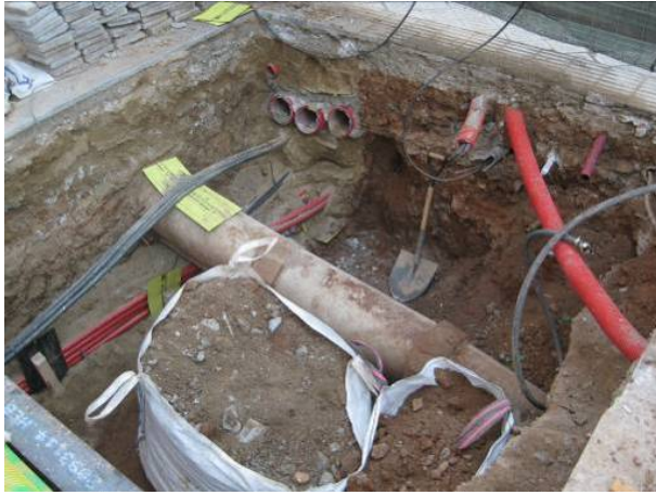
107. Serveis que afecten al subsòl en aquest tram
