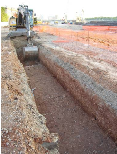
1. Vista del procés d'obertura d'una de les rases informatives
