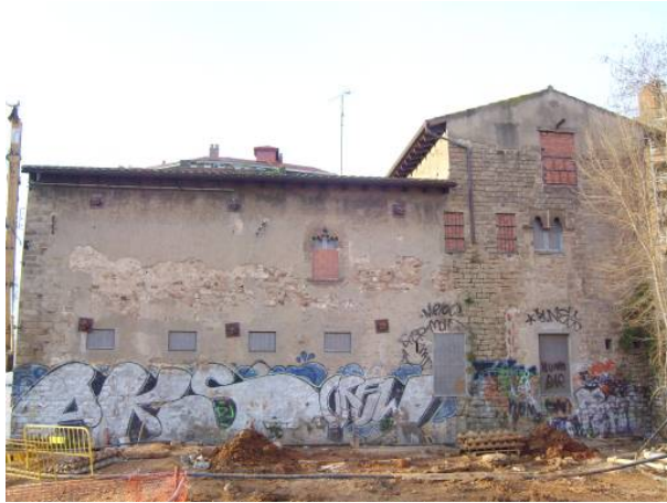
11. Façana septentrional de la Torre del Fang
