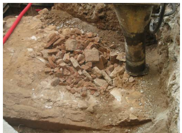
100. Desmuntatge de la coberta UE 307
