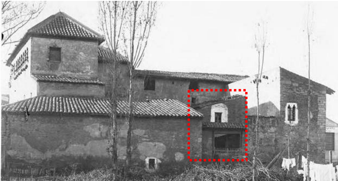
Vista de la zona del pati a principis del segle XX, on s'hi observa el nou cos a l'angle NO.
