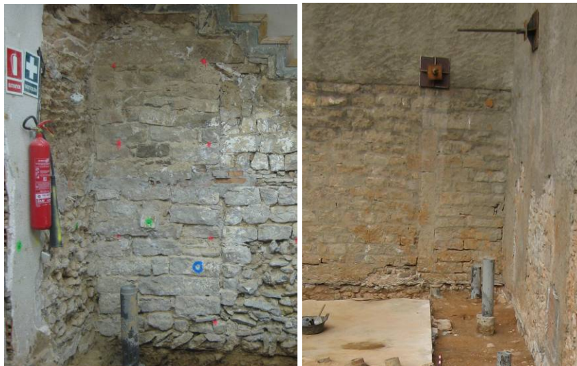
Obertura UE 1105 vista des de l'interior i exterior de l'edifici.
