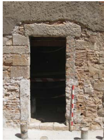
78. Vista exterior de la porta UE 6073, oberta en el mur UE 6070
