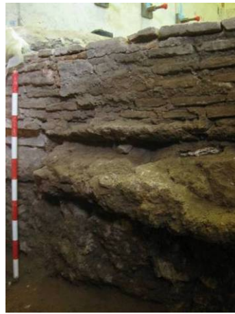
66. Detall del mur UE 2022 bastit sobre el fonament UE 2122.
